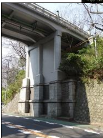
大手橋の下部
